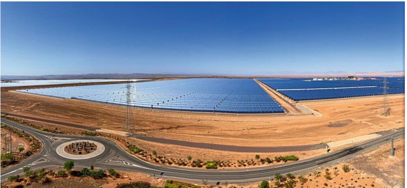
*Grüner Strom für grünen Wasserstoff: Die beiden Solaranlagen Noor 1 und Noor 2 im Bild sind Teil des Kraftwerks im marokkanischen Ouarzazate. Aktuell besteht die Anlage aus vier Feldern, eines davon ein Sonnenwärmekraftwerk. Die Gesamtleistung beträgt 580 Megawatt.*
